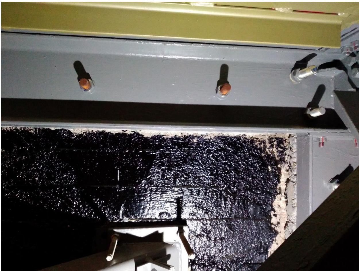
Fot. 9 - Wieniec W-1-1 po stronie wewnętrznej (kotwy M30 wklejone w narożnik muru).
