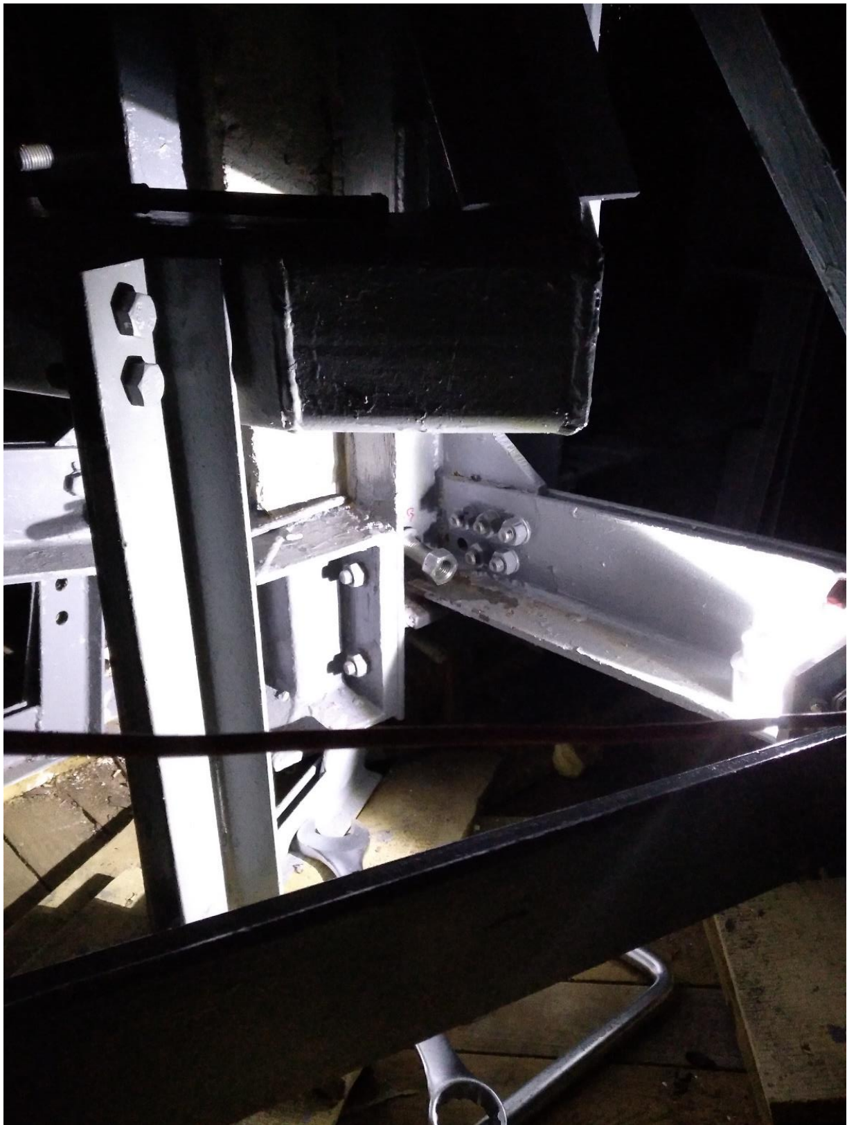
Fot. 13 – Pozostawiona kotwa wieńca W-2-3 (opis w sprawozdaniu technicznym).
