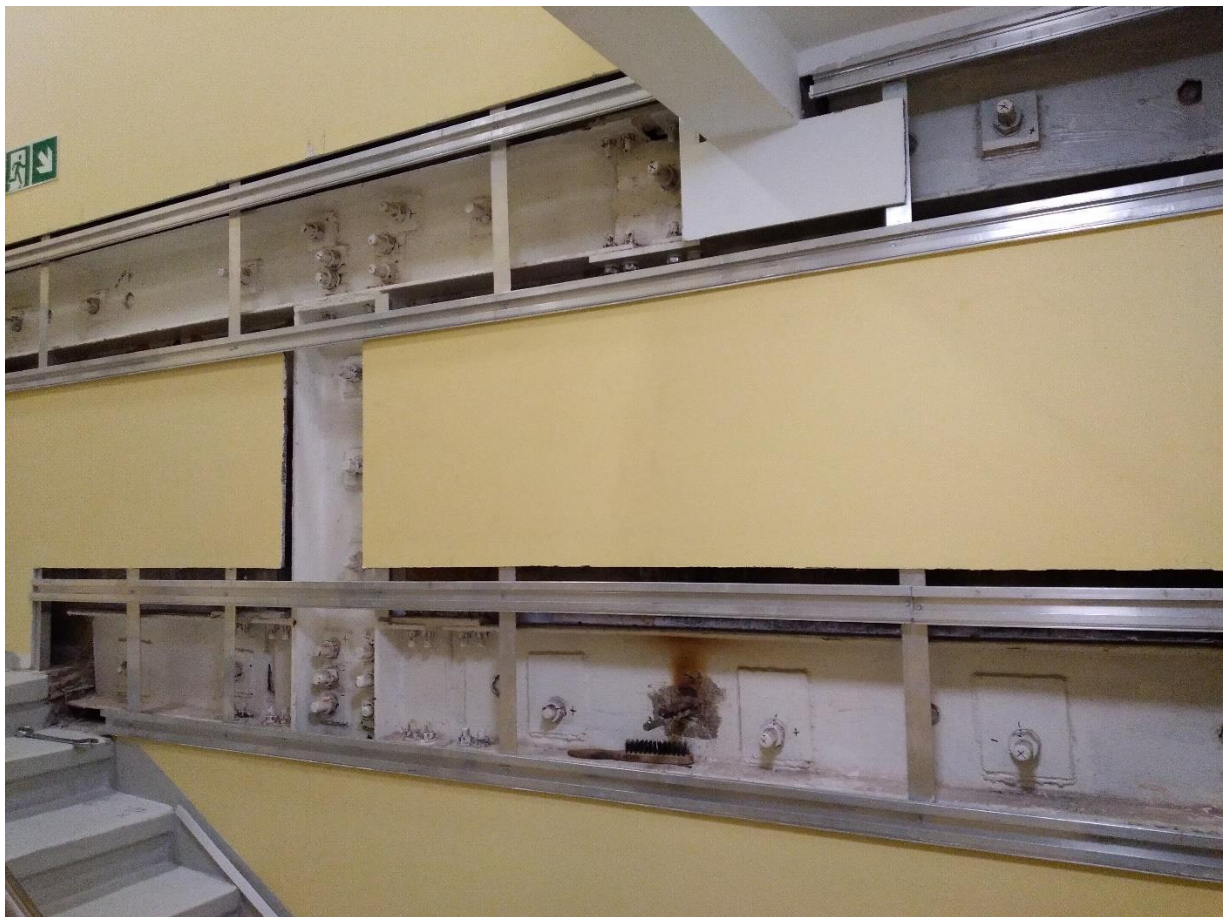
Fot. 3 – Wieniec zachodni od strony klatki schodowej. Widoczne kotwy M30.
