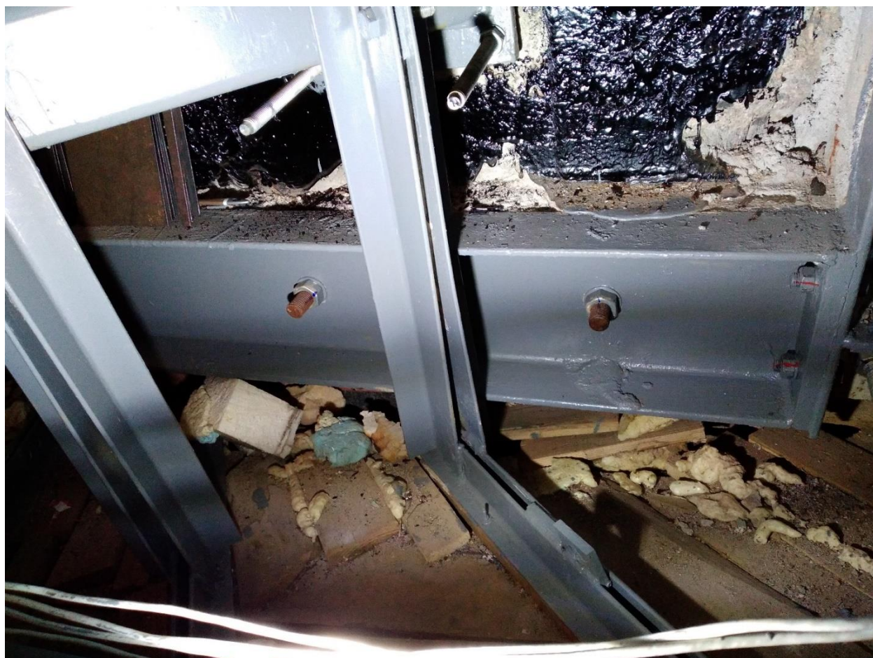
Fot. 10 – Wieniec W-1-2. Widoczna korozja gwintów śrub M30.
