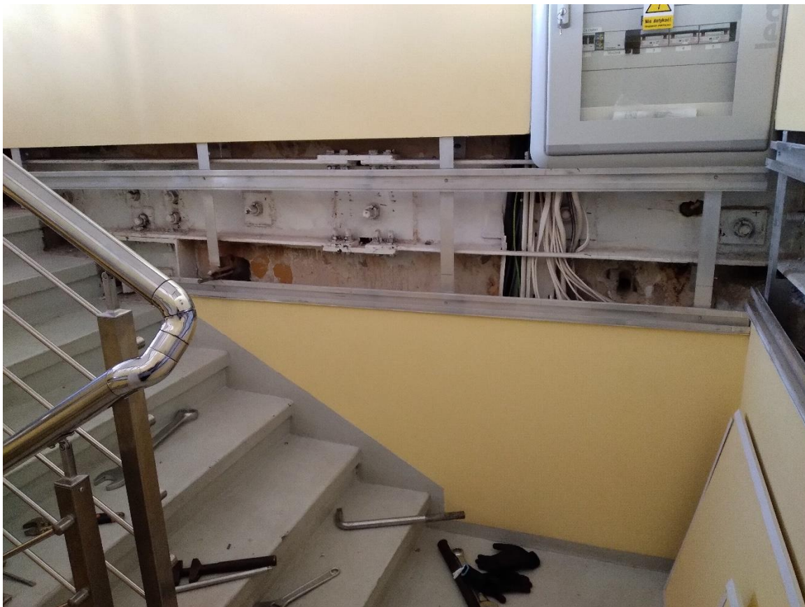
Fot. 5 – Wieniec wschodni (część górna) od strony klatki schodowej. Widoczne kotwy M30.
