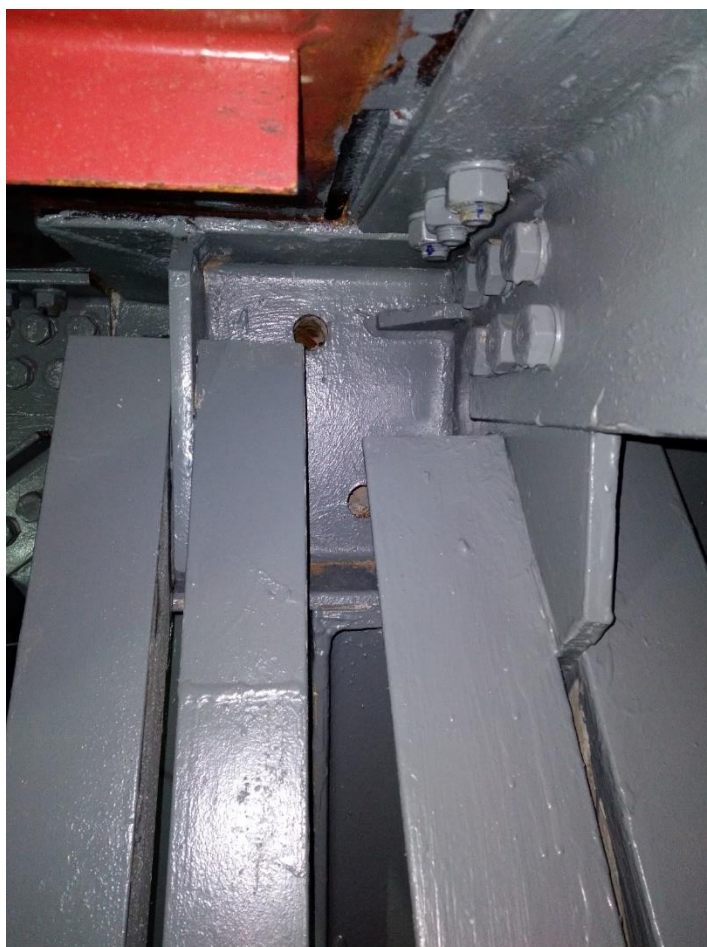
Fot. 12. Przygotowany otwór do wklejenia kotwy M30.
