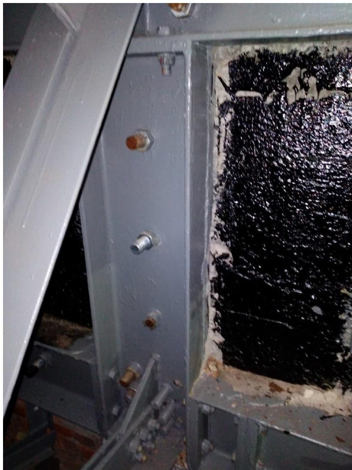
Fot. 11 Wieniec W-2-1. Widoczna korozja gwintów śrub M30.
