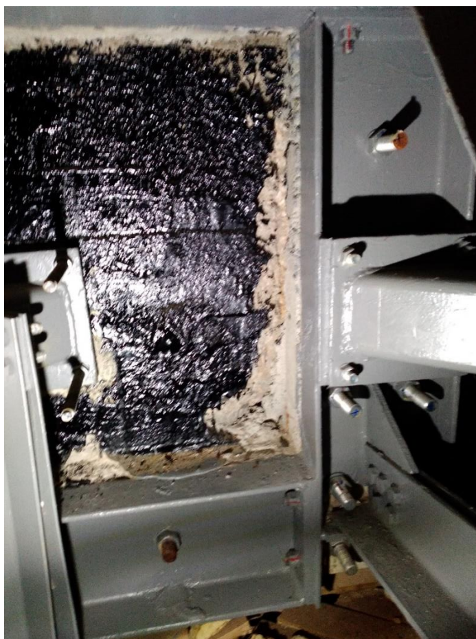
Fot. 8 – Wieniec W-2-2 po stronie wewnętrznej. Widoczna korozja gwintów śrub M30.
