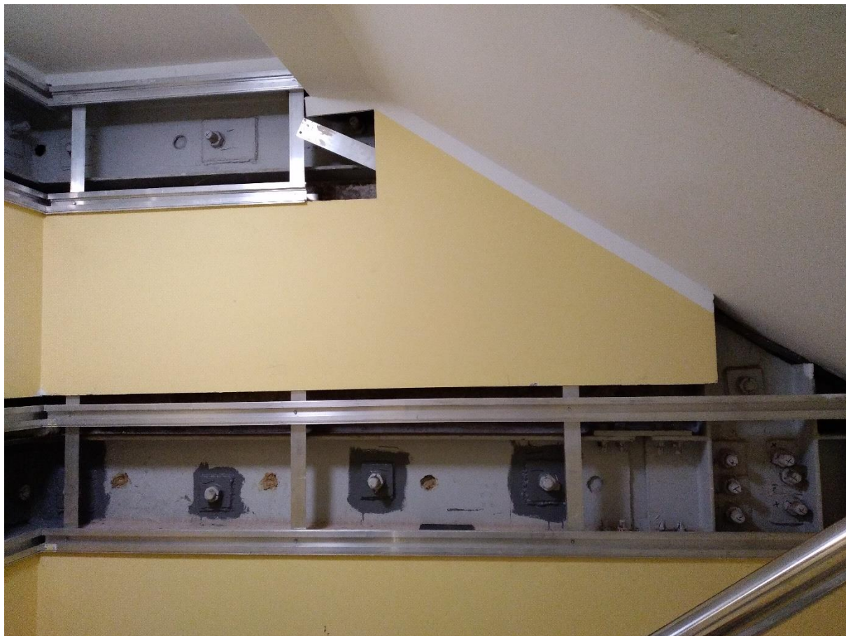
Fot. 1 - Wieniec wschodni od strony klatki chodowej. Widoczne kotwy M30.
