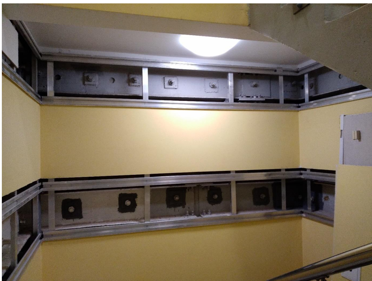
Fot. 2 Wieniec północny od strony klatki schodowej. Widoczne kotwy M30.
