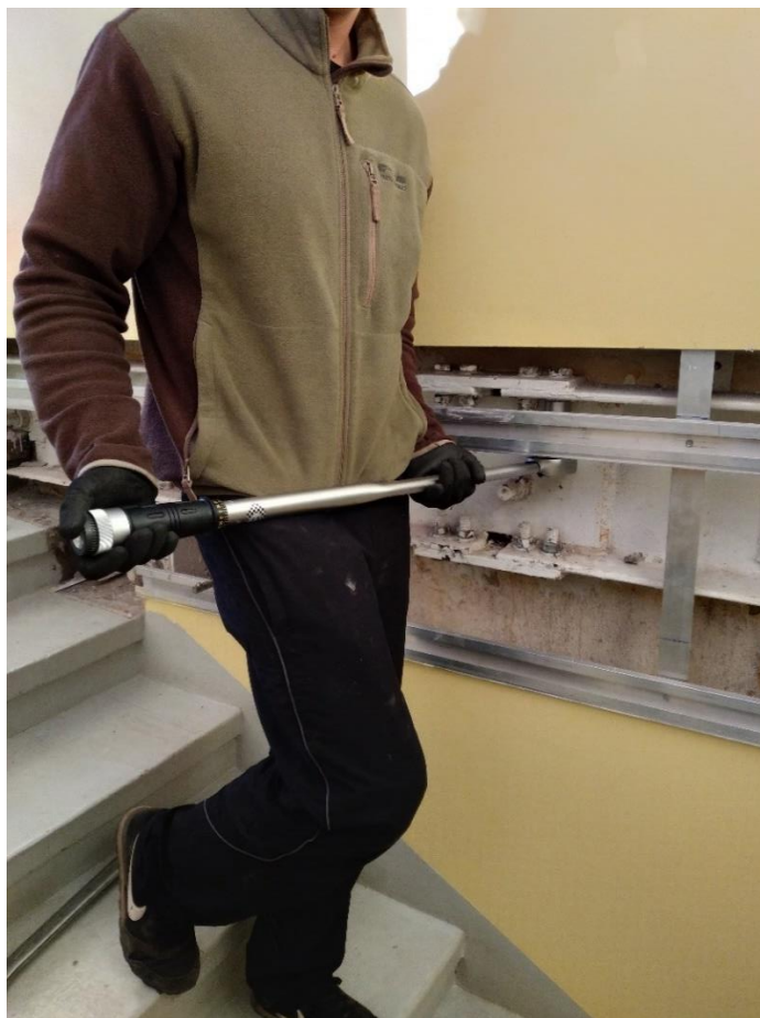
Fot. 7 – Sprężanie połączeń elementów konstrukcji.
