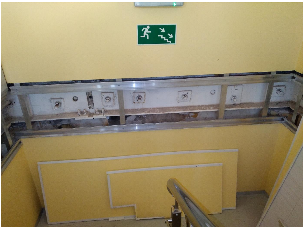
Fot. 4. – Wieniec południowy (część górna) od strony klatki schodowej. Widoczne kotwy M30.
